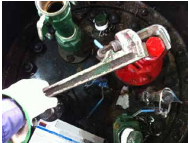
La foto arriba ilustra el uso apropiado de la herramienta para apretar el tapón.
