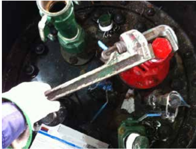
La photo ci-dessus indique le bon emploi de l'outil correct pour serrer le bouchon.
